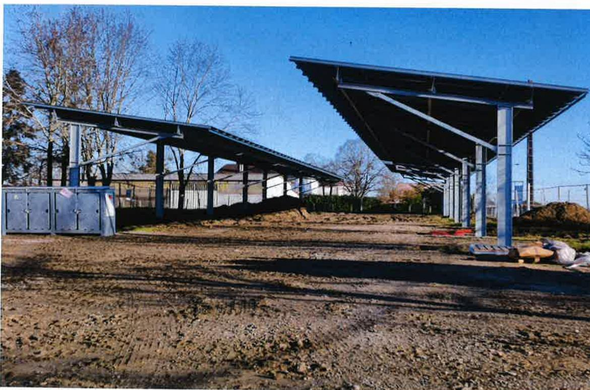
Le projet de couvrir le tennis est pratiquement terminé. Les structures sont montées, les panneaux solaires sont posés et raccordés entre eux. Il reste à raccorder l'ensemble au réseau électrique afin d'y injecter la production.
